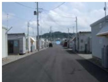
写真9 仮設住宅地 松永地区
